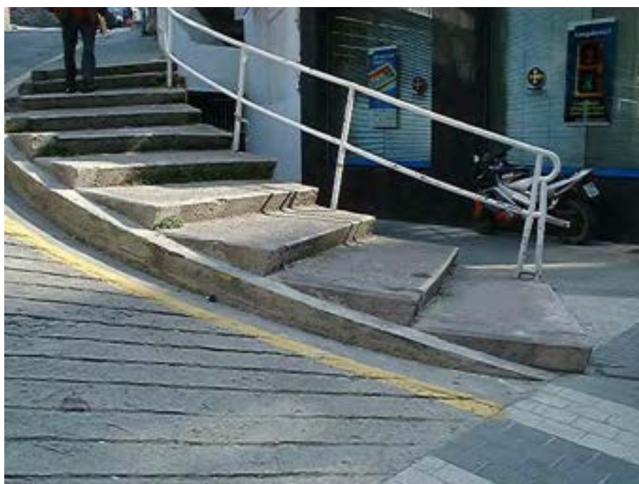
Escalera de directriz curva situada en acera. Dispone de una única barandilla y un solo pasamanos, lo que dificulta su uso para personas usuarias de bastón o muletas en los miembros afectados.
