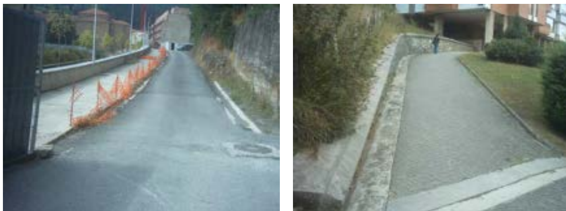
Tramos con pendiente superior al 6%
