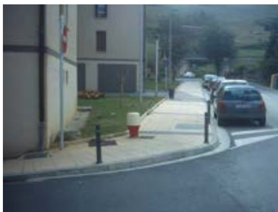
Señal y boca de riego mal ubicados
