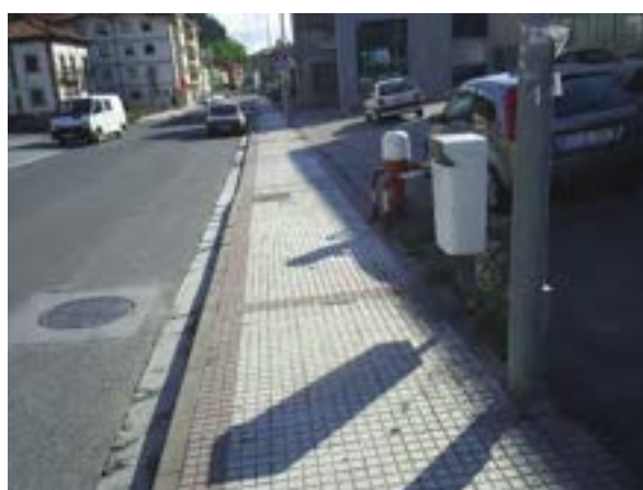
Aceras con pendiente transversal
