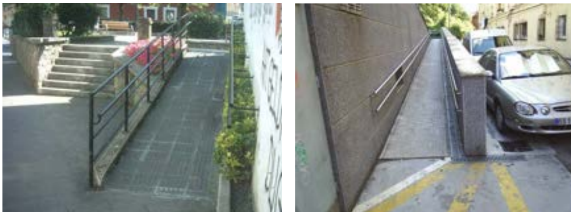
Desniveles a superar con rampas
