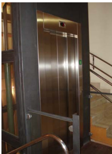
Sustituir cabina de ascensor.
