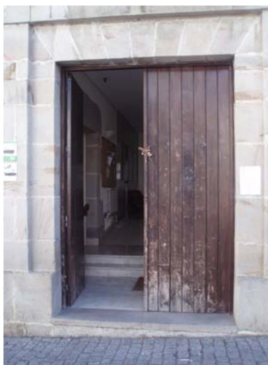
Salvar escalón de la entrada con una rampa.
