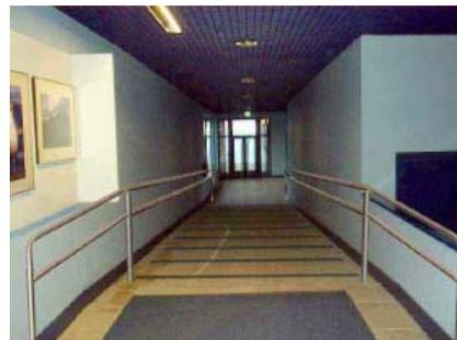
Los inicios y finales de rampas y escaleras deberían estar señalizados con franjas táctiles de pavimento diferenciado para ser fácilmente detectables por personas con dificultades visuales.
