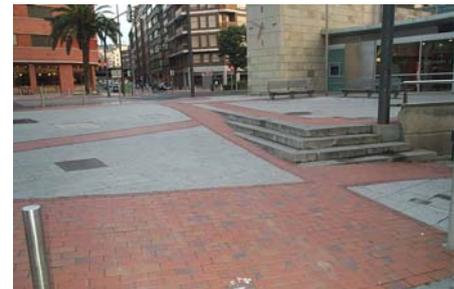
En el acceso de la escalera o rampa se deberá situar una franja señalizadora de 100 cm de ancho ubicada en la acera, perpendicular a la dirección de la marcha, cubriendo la totalidad del itinerario peatonal.
