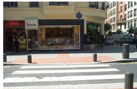
Esta señalización tiene que hacerse en la acera, utilizando un pavimento diferenciado que guíe a los peatones hasta el vado, indicando a la vez el cambio de pendiente del pavimento tal y como se ve en las fotografías. Se dispondrá una franja señalizadora de 1 m de ancho de pavimento de botones en el sentido transversal de la marcha para el peatón que circula por la acera.
