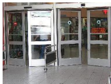
Las puertas acristaladas han de tener bandas señalizadoras horizontales colocadas de forma que sean fácilmente detectables por una persona que se aproxime a ellas. Estas bandas han de tener con un zócalo inferior de protección de 0,40 m y dos bandas señalizadoras horizontales (a 0,9 y 1,5 m) de 20 cm de anchura, contrastando con el resto de la puerta y el fondo del vestíbulo. Cuando se sitúen en un paramento acristalado se diferenciará la puerta para evitar problemas de localización visual
