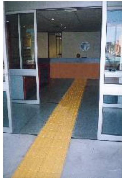
La Franja guía se dispone paralela al sentido de la marcha, realiza un itinerario continuo, sin intervalos, aún cuando existan cambios de cota o desniveles. Además, cuando haya puntos de intersección (la franja guía se divide en varias para llegar a diferentes puntos de interés) el pavimento de la franja cambiará, de manera que pueda ser detectado que existe esta diversificación de caminos
