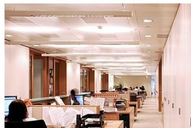
3. Las luminarias las colocaremos **uniformemente**, bien en línea y/o en las esquinas e intersecciones. Conseguimos de esta manera una iluminación adecuada y, además, una guía de dirección (orientación acerca del sentido/dirección de la marcha).
